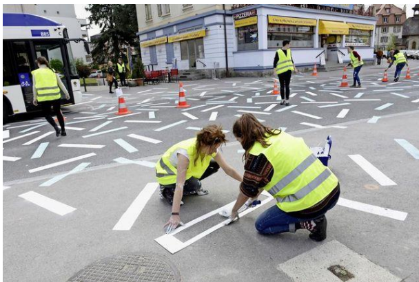
Figure 4 – Marquage de la zone de rencontre pour une phase de test sur la place de la Gare de Renens VD
