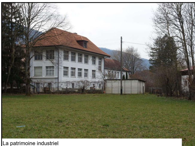
La patrimoine industriel
